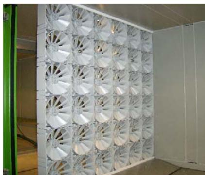
Блок модулей Vortex необходимо проверить на отсутствие загрязнений или повреждений в рамках ежегодного технического обслуживания. Возможные загрязнения следует удалить с помощью чистящего средства.
